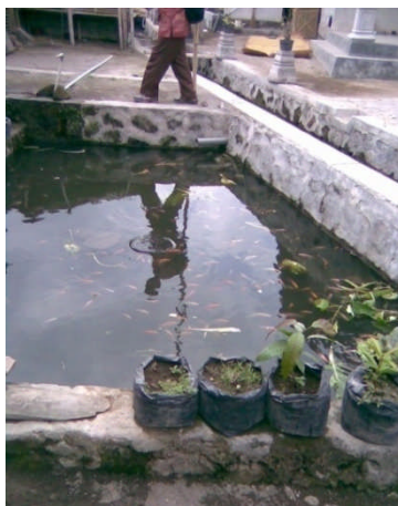
Gambar 5. Kolam Ikan dari pasangan batu
