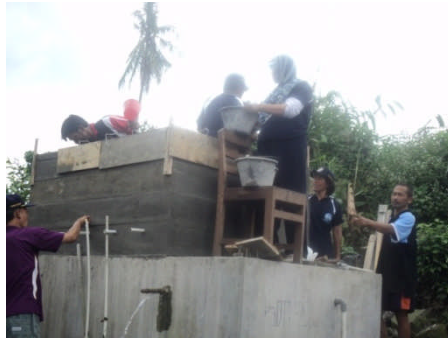
Gambar 3. Pembuatan Bak Reservoir
